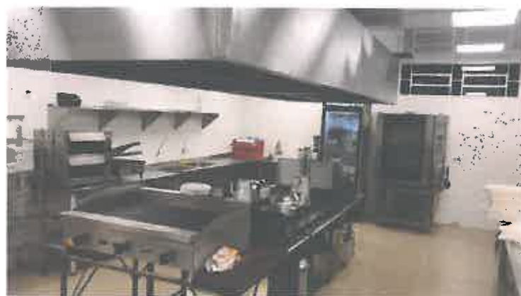
VISTA GERAL COZINHA REFORMADA
